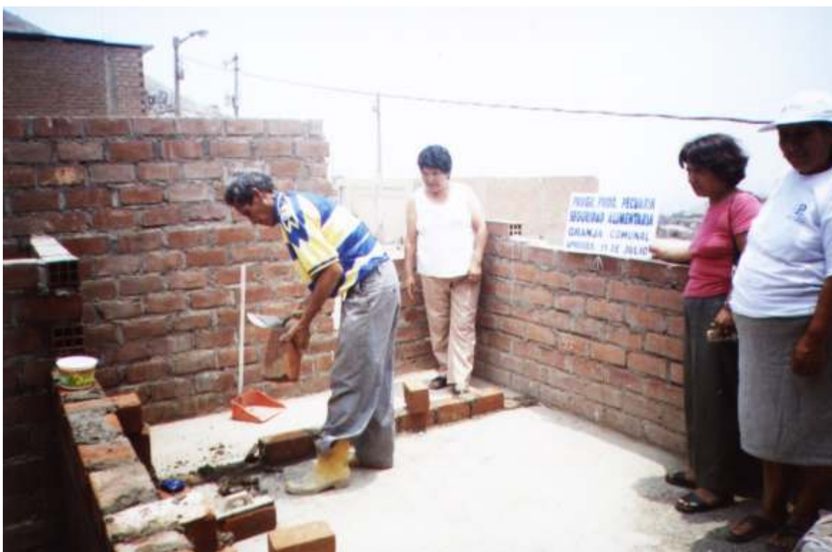
Visita a Comedor Autogestionario "Once de Julio" , en construcción de pozas para granja comunal de cuyes.
